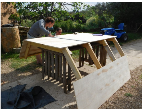
Fixation habillages latéraux extérieurs
