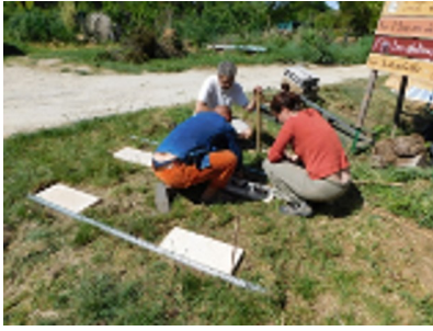
Terrassement Pose dalles béton
