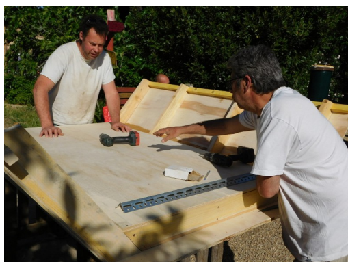
Pose habillage de fond intérieur
