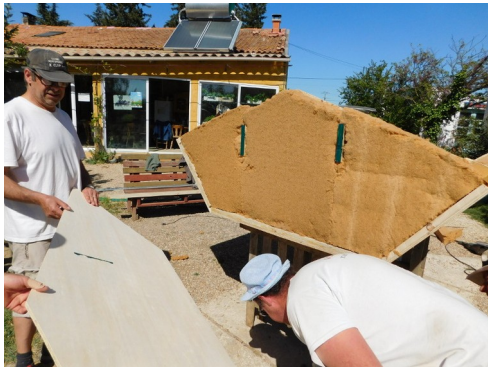
Isolation joue haute et marquage position raccord de joues
