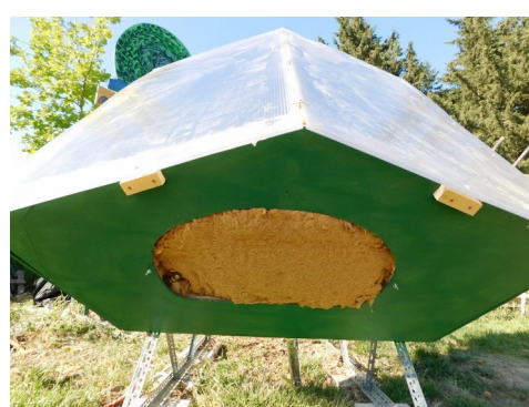
Isolation ouverture et pose couvercle
