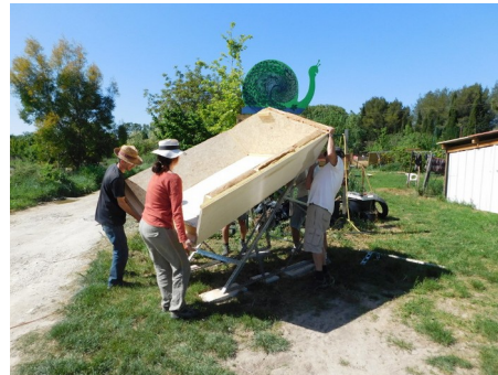
Pose structure bois sur structure acier
