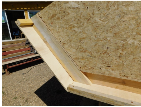
Pose joue intérieure haute et liteau de fixation de joue extérieure
