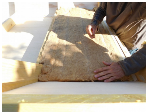
Pose isolation de fond
