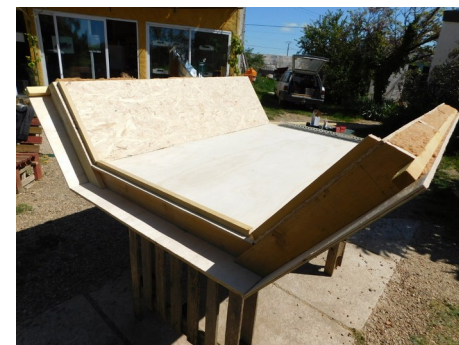
Isolation et pose habillage latéraux intérieurs
