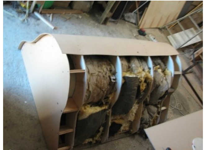
Habillage arrière, les profilés bois fond 15 cm de large, il y aura donc cette épaisseur d'isolant tout autour du CESS.
